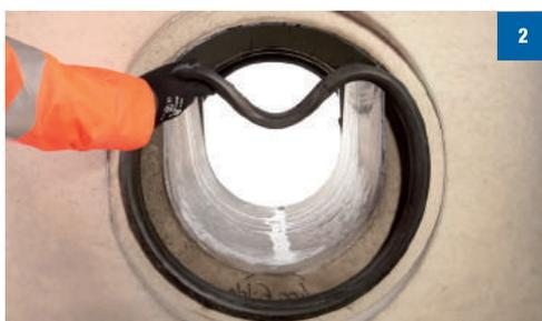
Poser le joint en appui sur la face extérieure béton tout en formant un « cœur » en sa partie supérieure.
