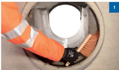
Avant la pose du joint de branchement, nettoyer la réservation béton à l'aide d'une brosse.
