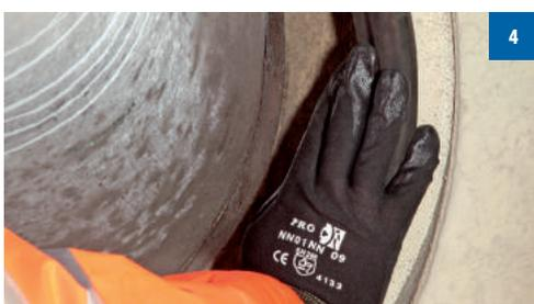
Une fois le joint monté, s'assurer qu'il est en butée sur la paroi béton en tapant avec la paume de la main sur toute sa circonférence.
