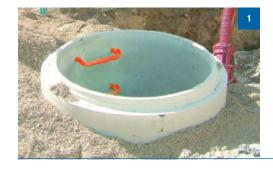
Poser les éléments droits jusqu'à la hauteur souhaitée (hauteur multiple de 150 mm).
