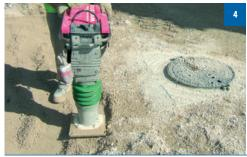
Remblayer autour de la dalle en respectant les préconisations de mise en œuvre du Fascicule 70. Poser l'enrobé pour une mise en service immédiate.
