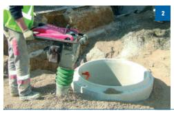
Remblayer autour des éléments avec un remblai traditionnel compacté ou remblai maigre jusqu'au niveau de la chaussée moins la hauteur de la dalle de répartition soit 240 mm.
